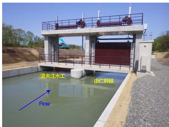
写真-1 道央注水工分水工の分水状況
