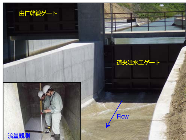
写真-5 道央注水工分水工のゲート操作と流量観測
