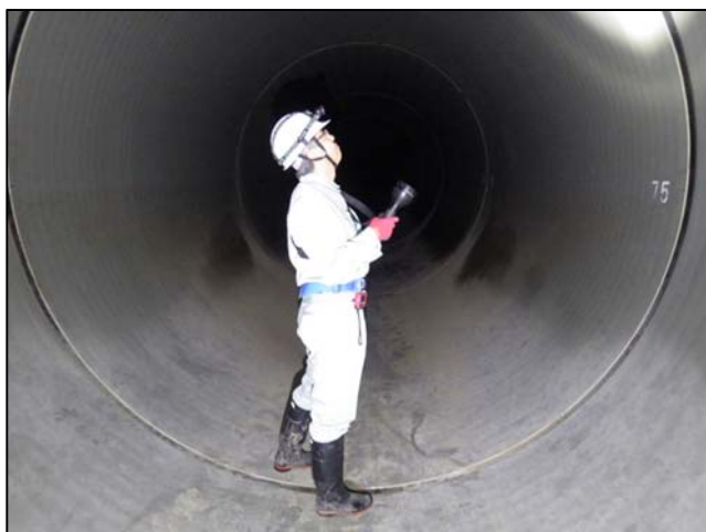
写真-2 目視点検状況
