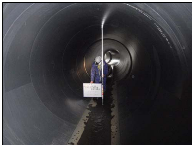
写真-3 たわみ量の計測状況
