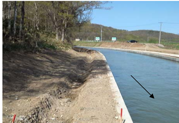
写真-2 改修後の右岸バーム
