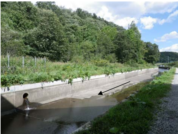
写真-1 改修前の右岸形状
