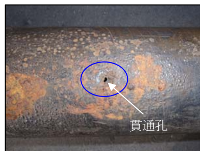
写真-5 立上げ鋼管の貫通孔
