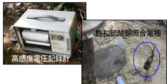
写真-12 管対地電位調査の様子
