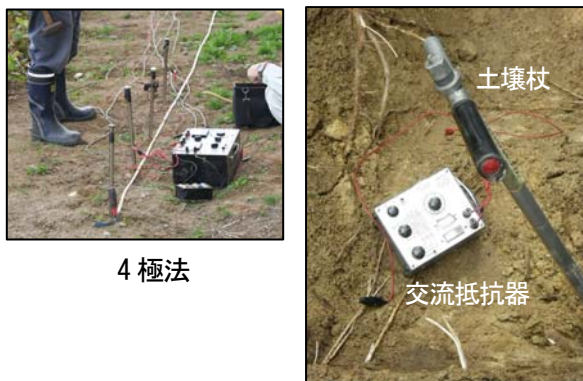
写真-11 土壤抵抗率調査の様子
