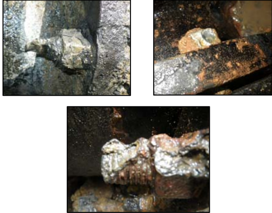
写真-8 継手部のボルト・ナットの減肉
