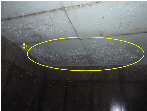
写真－１ 弁室A 側壁と頂版断熱材の状況
