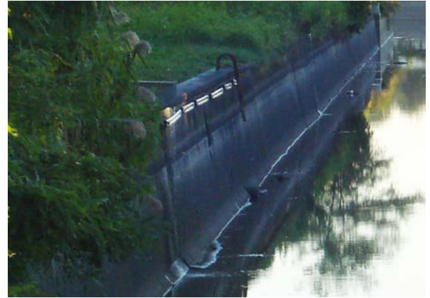
▲北海幹線用水路傾倒箇所補強状況(茶志内)
