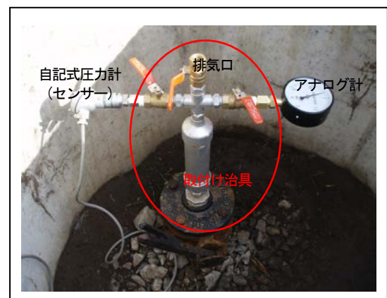
写真-1 治具と圧力計の設置状況
