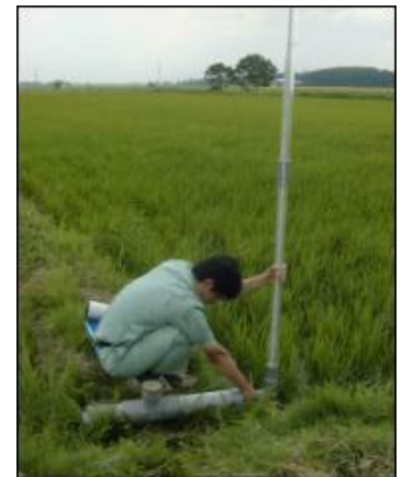
写真-3 マノメータ取付状況
