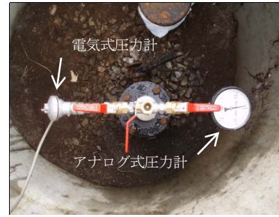
写真-1 圧力計取付状況
