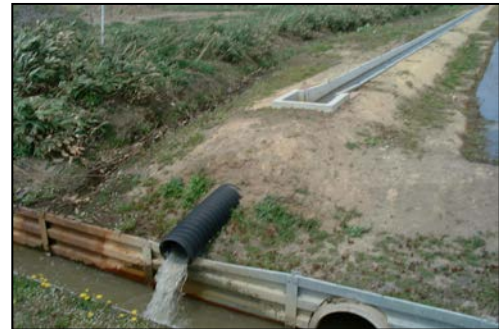
図-4 開水路末端での無効放流の例
