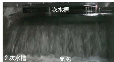
写真-5 落下水脈による気泡の発生事例
